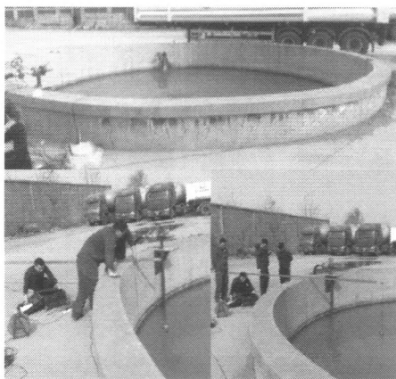
图 12 水池定位现场测试
